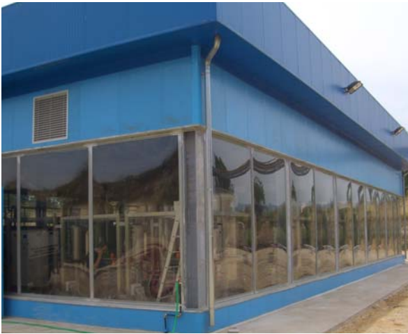
Locale distillazione percolato
